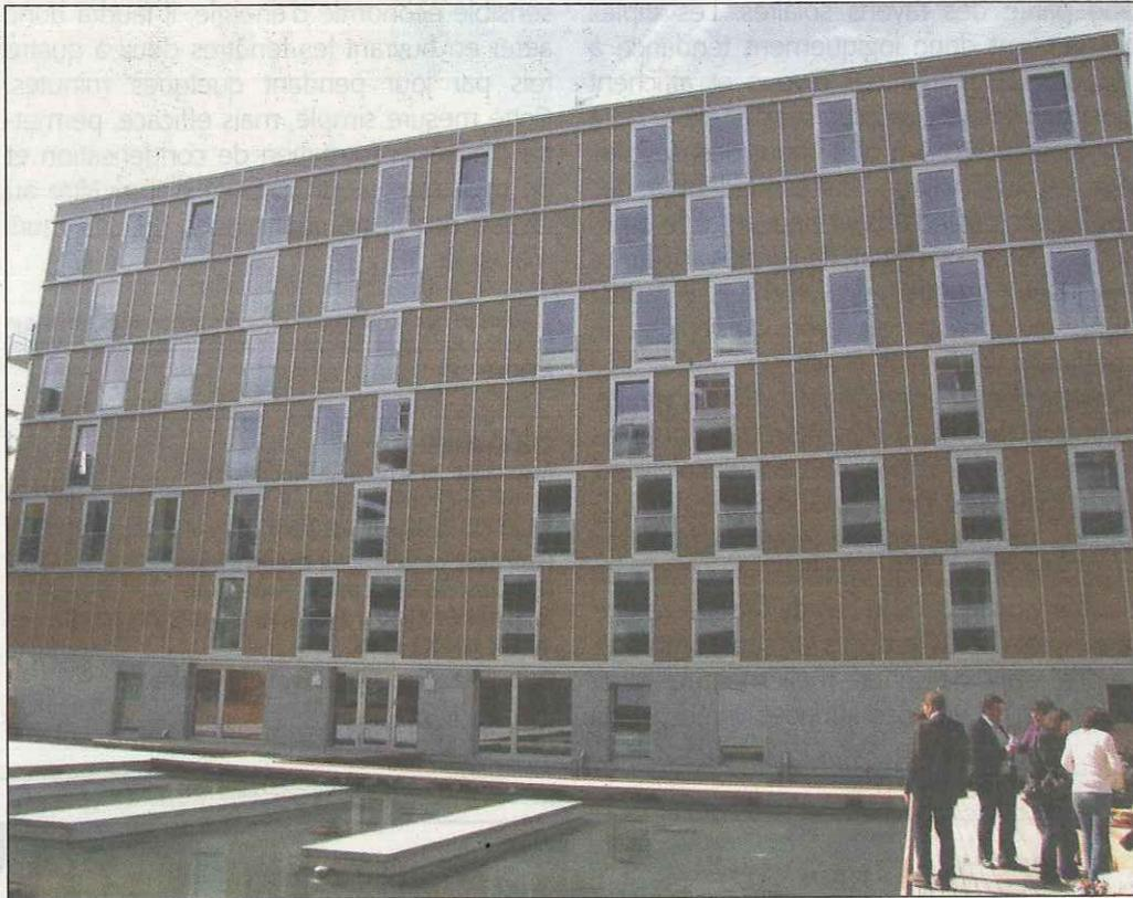
La façade solaire Lucido permet une économie de chauffage de 70% à 80%. En-dessous, on aperçoit les bassins de récupération d'eau pluviale.
