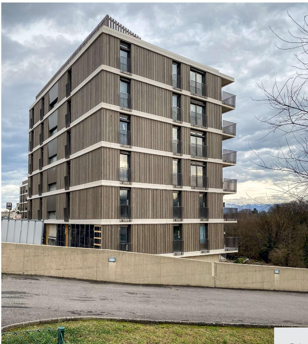
La structure béton est habillée d'un bardage bois. Des têtes de dalles préfabriquées soulignent les étages et participent au dynamisme de l'ensemble.
