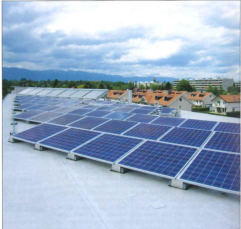
En toiture, quelque 100 m<sup>2</sup> de panneaux photovoltaïques produisent environ 10 000 kWh/an. On distingue au fond les capteurs solaires pour la préparation de l'ECS.
