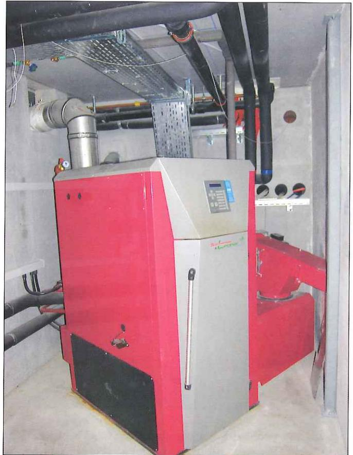
La chaudière à pellets en appoint aux capteurs thermiques.
